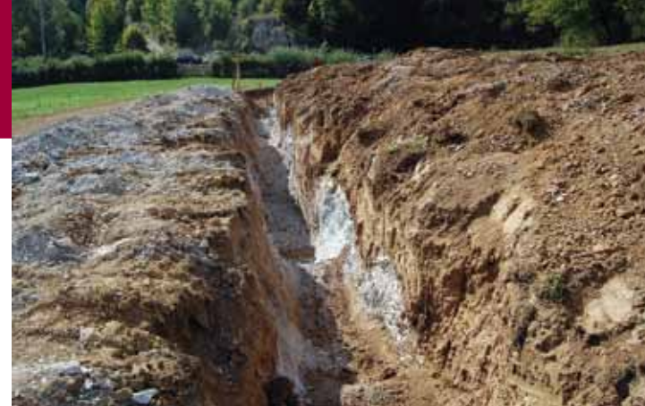
Kanalizacija u MZ Ljubijankići
